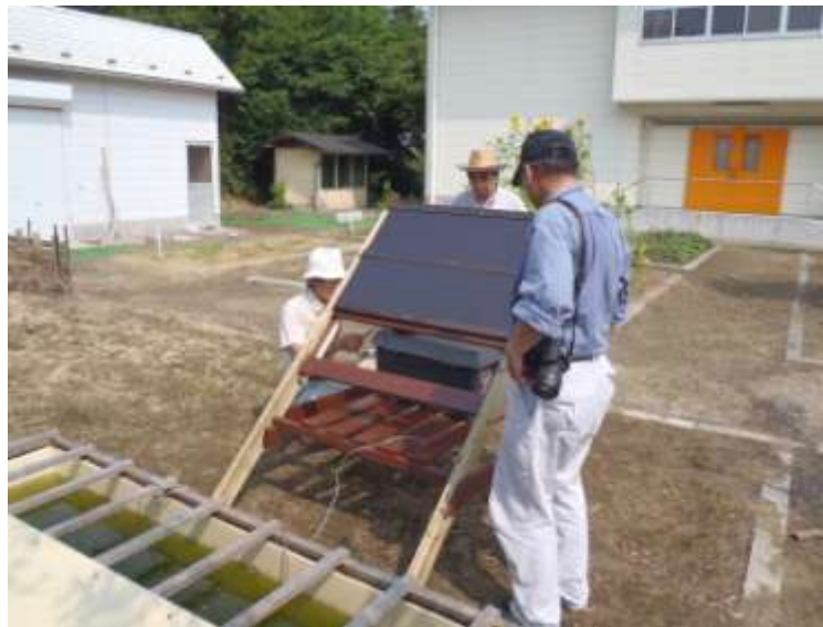
ソーラー発電システムの設置風景 手前が水槽 7月後日、ソーラーパネルを3枚に増設しました。
