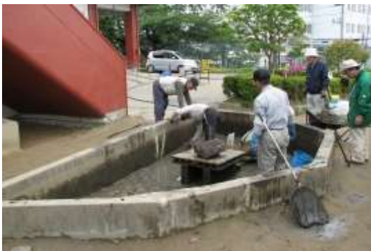
2012年5月30日鹿島台小学校(大崎市) 池の水を抜いて壁の補修や掃除を行う
