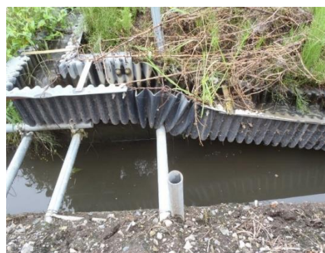
写真－２ 自在エルボの落差はだめ
