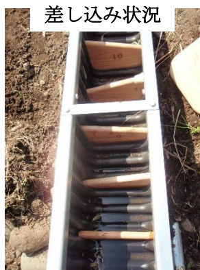
写真－９ 魚道と水田との接続
