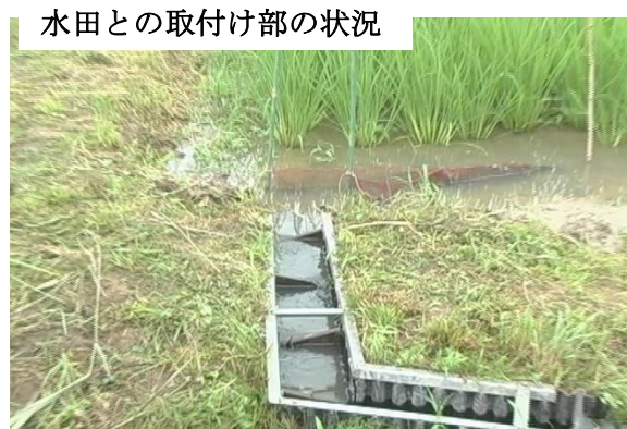
写真－９ 魚道と水田との接続
