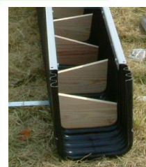
堰板の挿入状況
