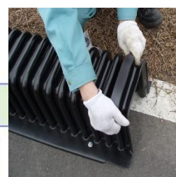
止水パッキン取付
