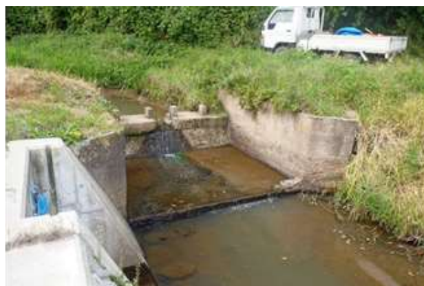
図 5 オオクチバスの遡上を防ぐ農業用取水堰
