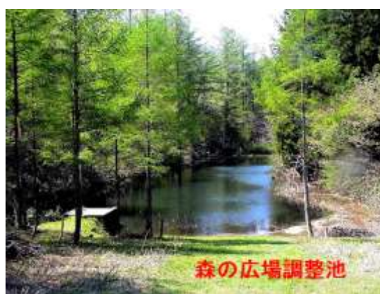
写真-6 細流を堰き止めた調整池
